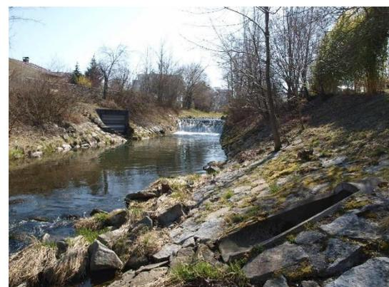
Maßnahmen: Entnahme der Sohlsicherung, tlw. Entnahme der Ufersicherungen, Abflachen der Ufer, Einbau von Strukturen in Form von einzelnen Wurzelstöcken und kombinierten Buhnen. Anbindung an den Ottenbach: Tümpelpass mit Steinriegeln und V-förmigen Schlitzten.
