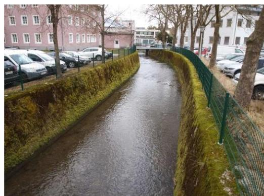
beschattet wird, wird auf einen Einbau von Bühnen mit vorgesehenem Bewuchs verzichtet und lediglich Wasserbausteinbühnen verbaut.
